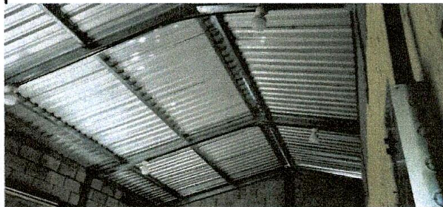
Foto 8: costaneras de metal instaladas
