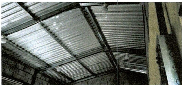
Foto 7: iluminación eléctrica instalada
