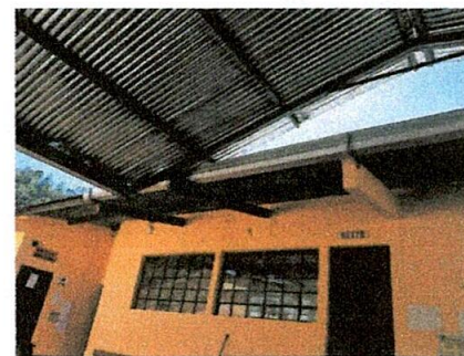
Foto 6: Canal de metal instalado
