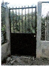
Foto 3: Portón de metal instalado
